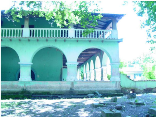
Vista parcial de la fachada Sur de la casa patronal de la Hacienda Santa Barbara.
