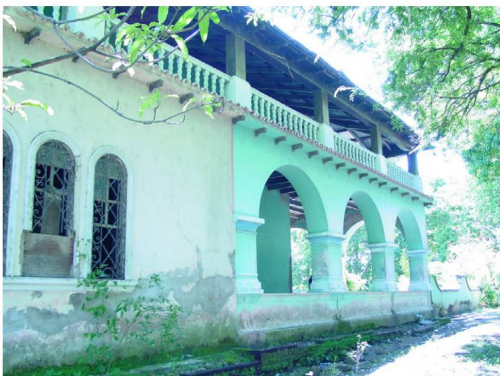
Vista de la fachada Sur. Arcadas en el primer nivel y galeria abierta en el segundo
