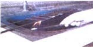
CALENTAR HASTA OBTENER 3 EMISIONES DE VAPOR. APAGAR ANTORCHA Y ESPERAR COMPLETAR 5 MINUTOS
