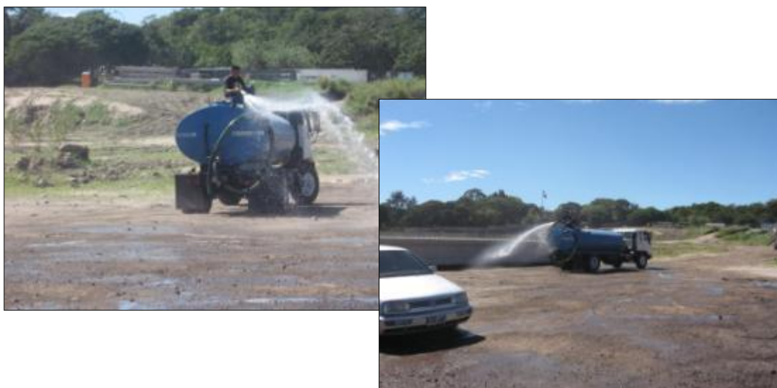
Figura 6. Camión cisterna con equipo de bombeo similar al que sería utilizado para el control de finos durante las actividades de construcción.
