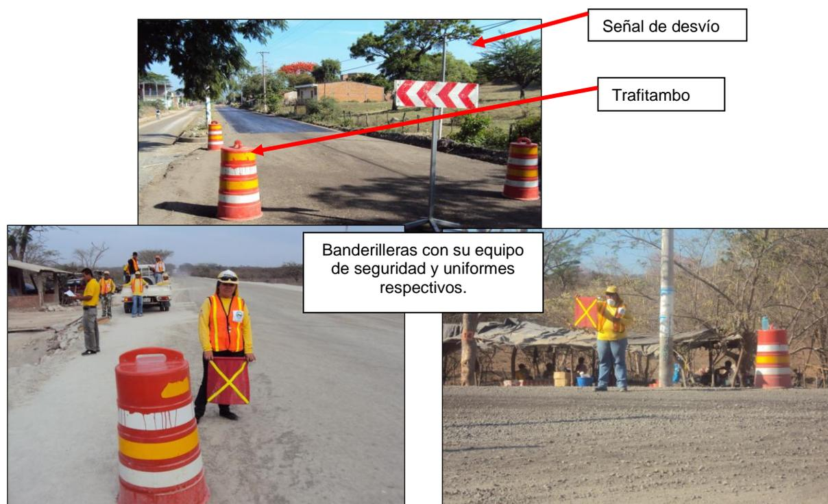
**Figura 6.5** Ejemplo de señalización y control del tráfico durante las actividades de construcción.
