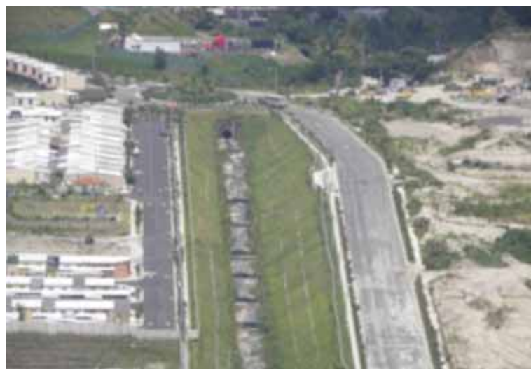
Foto 2. Drenajes de aguas lluvias. Fuente: Marielos Marín.
