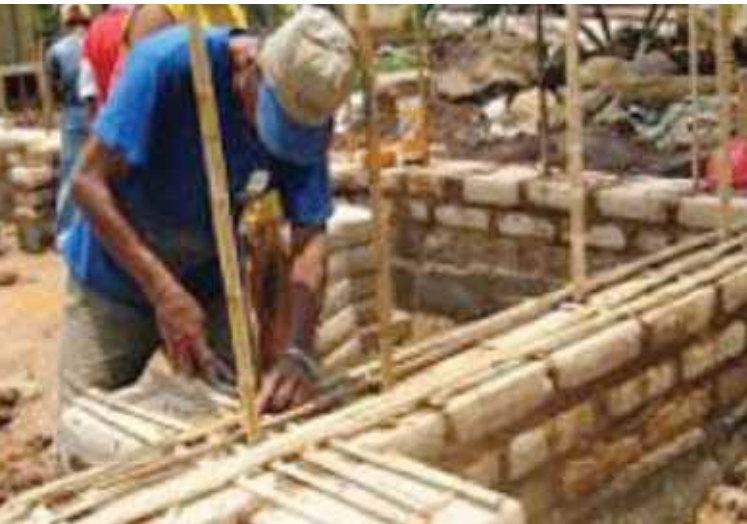
Foto 2. Construcción de vivienda de adobe estructural (FUNDASAL).
