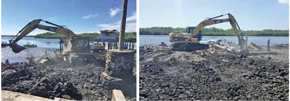
Inicio de la demolición de la plataforma de la Fuerza Naval, al final del muelle, con maquinaria del MOP y aportes de la alcaldía. 17 de noviembre de 2016.
