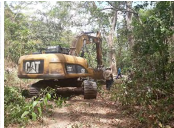
Construcción de las obras de protección contra inundaciones. Marzo de 2018.
