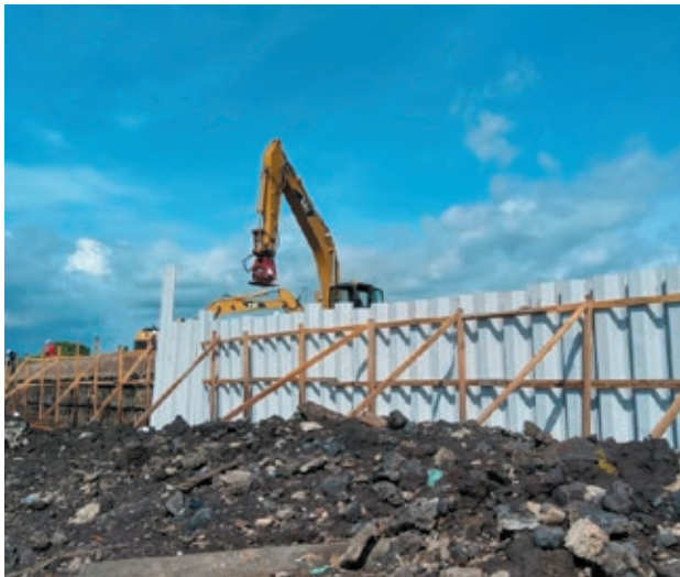
Colocación del sistema de tablestacado en el costado poniente del muelle – Octubre 2018.
