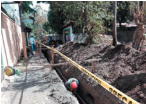
Zanjeado para colocación de tuberías en el casco turístico
