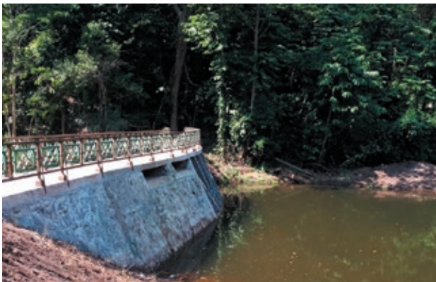
Dique de protección en río Amayo – Diciembre 2019
