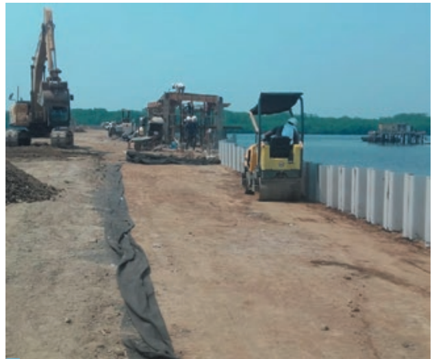
Trabajos en las rotondas Mayo 2019.
