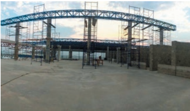
Avance en las obras de construcción. Mayo 2019
