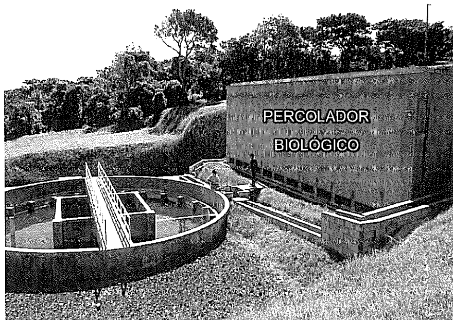
Fotografía 3. Filtro percolador biológico, nótese el desnivel requerido (mínimo 3.0 m) para recolectar el agua al fondo y llevarla al sedimentador secundario tipo Dortmund
