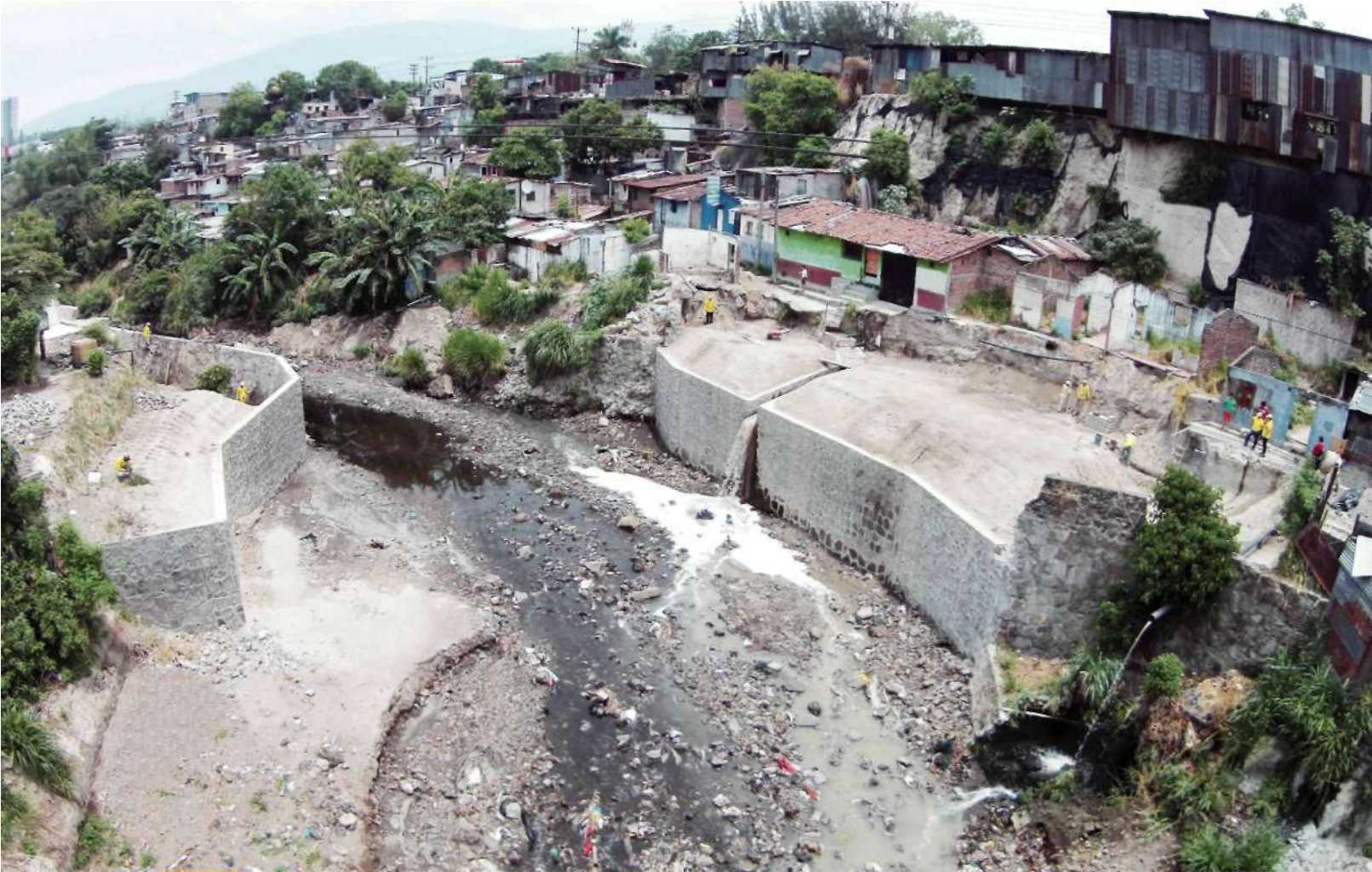
Trabajos de mitigación de riesgos en la comunidad Nuevo Israel, San Salvador.
