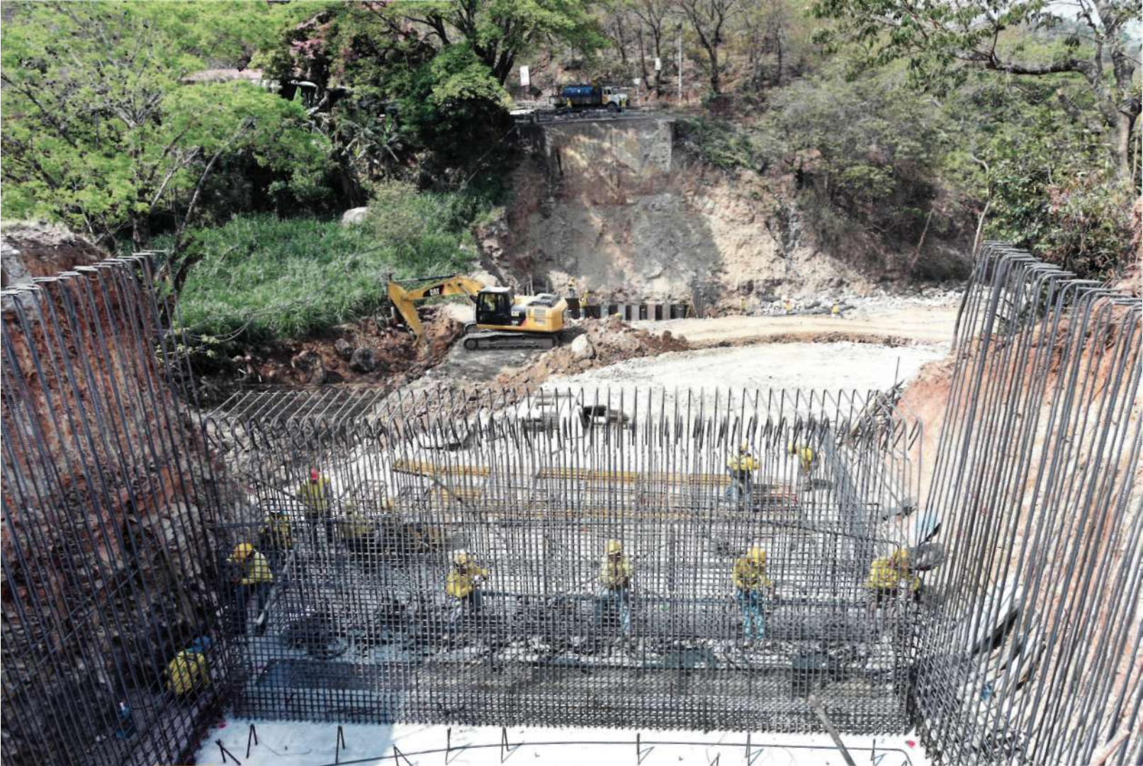
Obra de paso. Trabajadores durante ejecución de puente La Palma, en Chalatenango.
