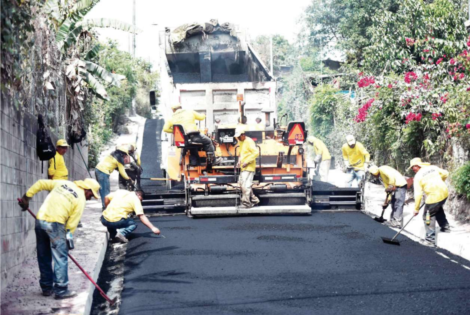
Mejoramiento de caminos en comunidad El Castano, Soyapango.
