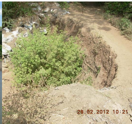
Fotos 3 y 4 Obsérvese la cantidad de material arenoso depositado en el sitio inspeccionado y la cárcava formada a unos 150 m aguas abajo de lugar en donde se ubica la borda colapsada.
