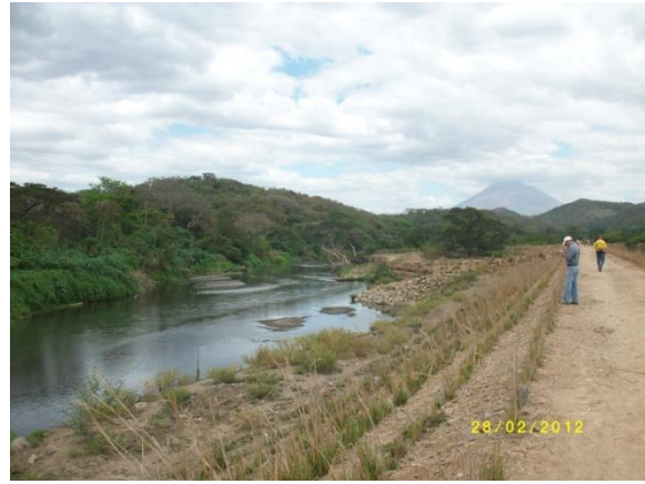
Fotos 7 y 8. Borda construida en el año 2008, durante la última época lluvia no ha sufrido daños y está ubicada aguas arriba del sitio donde la borda vieja colapso.
