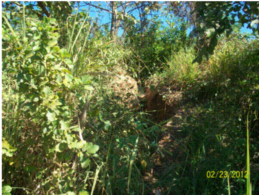
Foto 17, Muestra una fisura de gran tamaño
