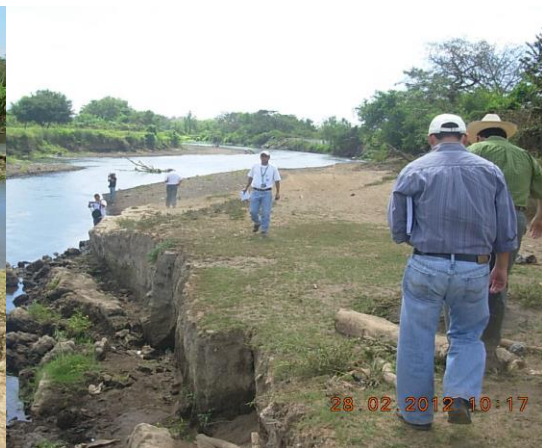
Fotos 1 y 2 Obsérvese el daño en la borda la cual colapso y el río se introdujo en los terrenos aledaños; además, las márgenes han sido dañadas por la erosión.
