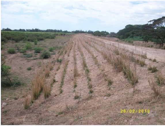
Fotos 7 y 8. Borda construida en el año 2008, durante la última época lluvia no ha sufrido daños y está ubicada aguas arriba del sitio donde la borda vieja colapso.
