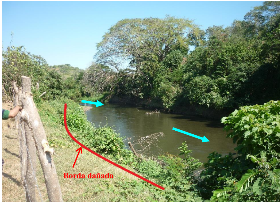
Fotografía 1: Sitio en donde el río realiza su giro y borda dañada.
