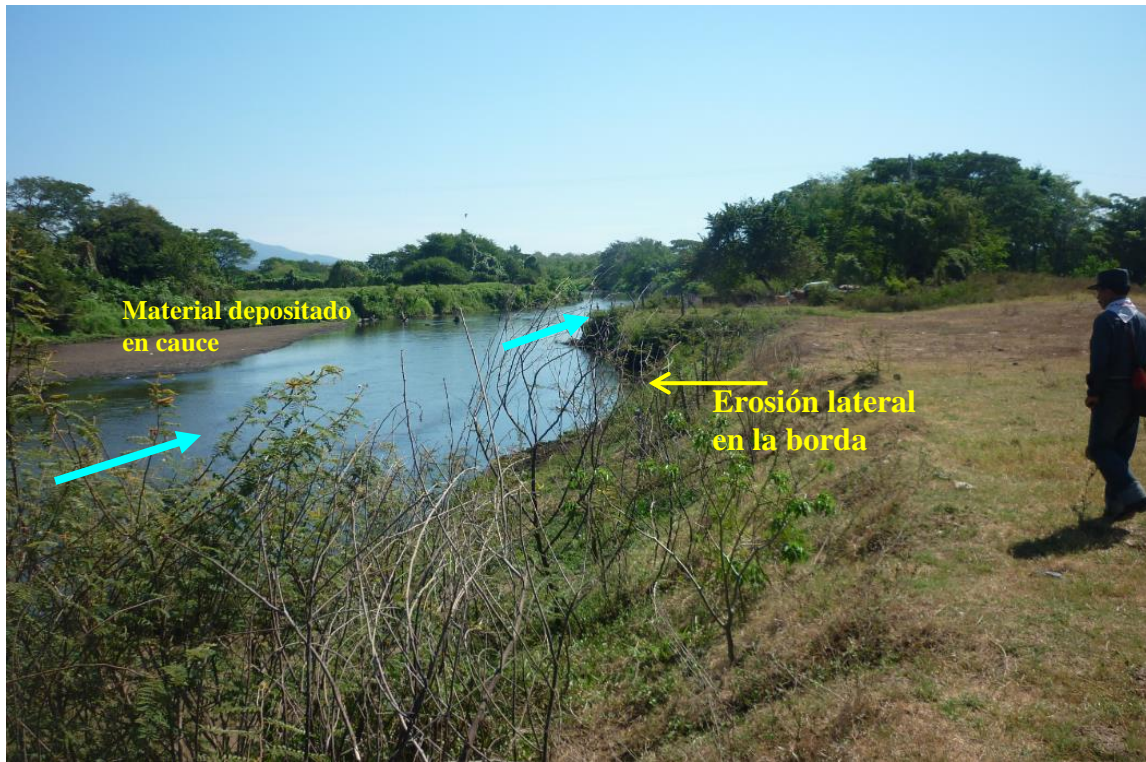
Fotografía 5: Erosión Lateral de borda en el tramo La Zorra
