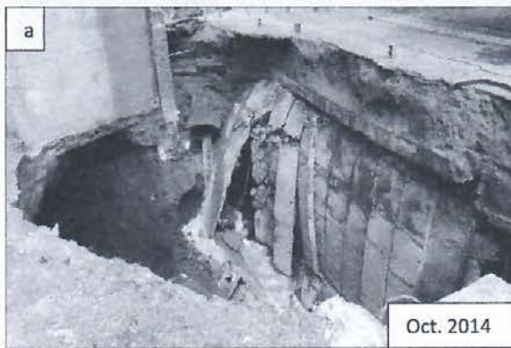
Fotografía N°1. Colapso de boveda en intercepcion de calle principal y senda No 10 en Brisas de San Francisco a) foto de colapso sin obras de mitigacion b) foto de colapso con obras de mitigacion.
