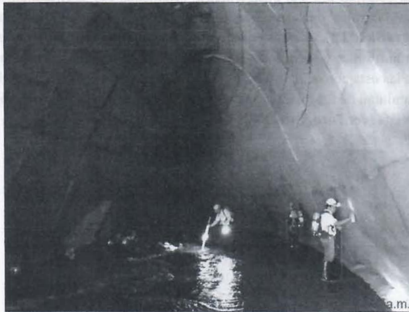
Fotografía N°10. Curva para cambio de dirección del flujo en alineamiento de bóveda, entre las estaciones 0+40 y 0+60.
