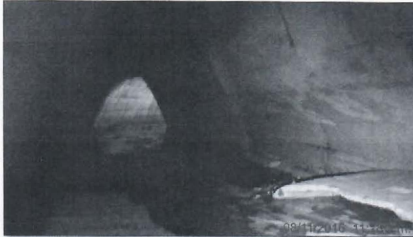
Fotografía N°13. Cambio de sección en bóveda (estacionamiento 0 + 90)
