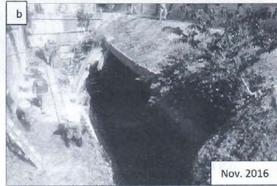
Fotografía N°1. Colapso de boveda en intercepcion de calle principal y senda No 10 en Brisas de San Francisco a) foto de colapso sin obras de mitigacion b) foto de colapso con obras de mitigacion.
