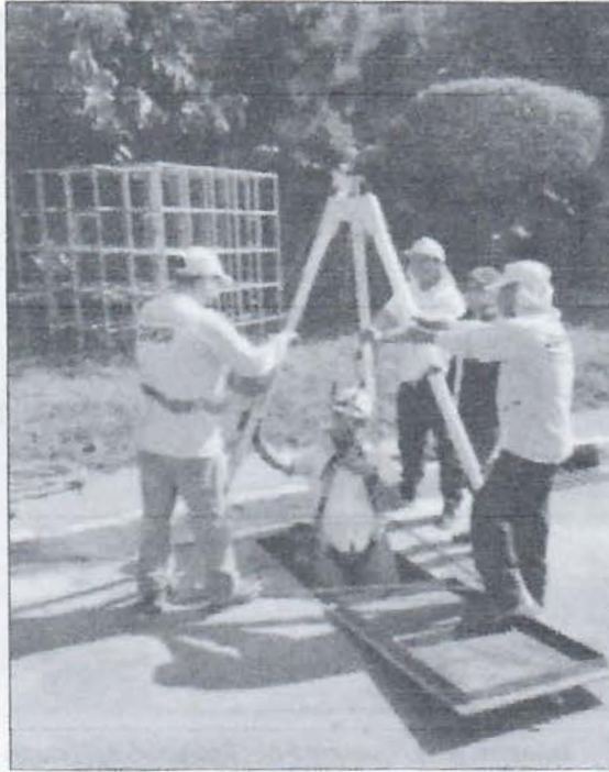
Fotografía N°7. Ingreso del tramo 3 por medio de caja de inspección
