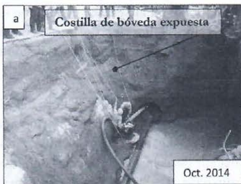
Fotografía N°2. Hundimientos por perdida de relleno en sistema de aguas negras a) hundimiento previo a colapso de boveda en senda No 10 b) hundimiento actual en senda No 8.
