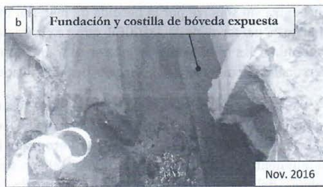
Fotografía N°2. Hundimientos por perdida de relleno en sistema de aguas negras a) hundimiento previo a colapso de boveda en senda No 10 b) hundimiento actual en senda No 8.
