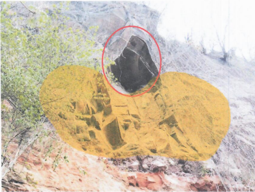
Fotografía 8. Vista desde base del talud.
