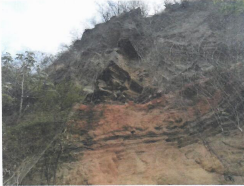
Fotografía 7. Vista desde base del talud.
