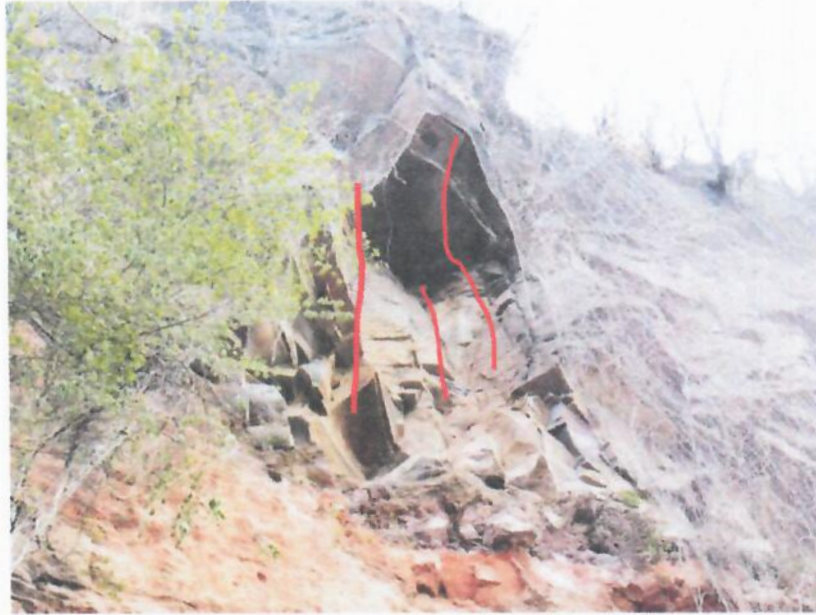
Fotografía 9. Vista desde base del talud.
