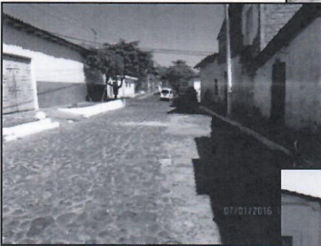
Imagen 7. Empedrado con deformaciones
