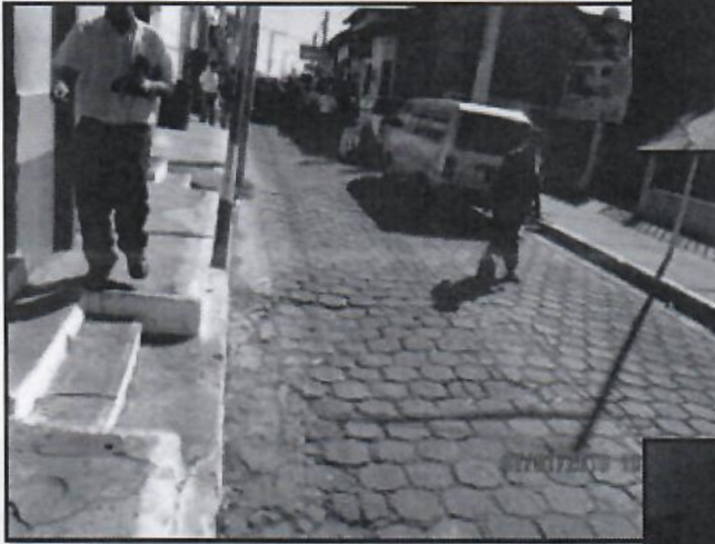
Imagen 3. Deformaciones en el adoquín
