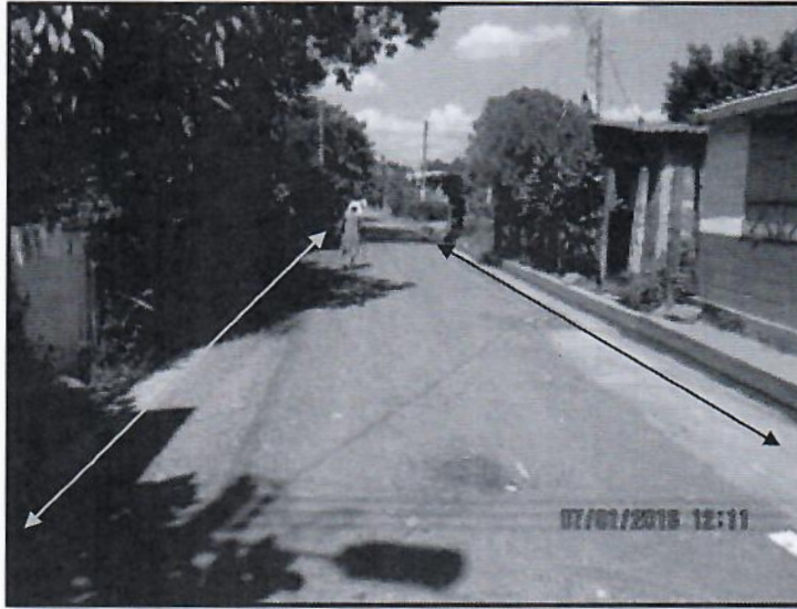
Imagen 3. Drenajes laterales en buenas condiciones
