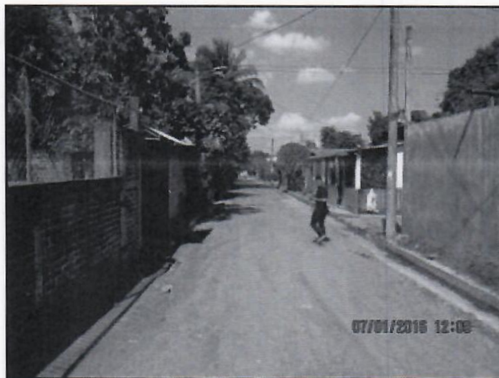
Imagen 2. Superficie balastada en buen estado.
