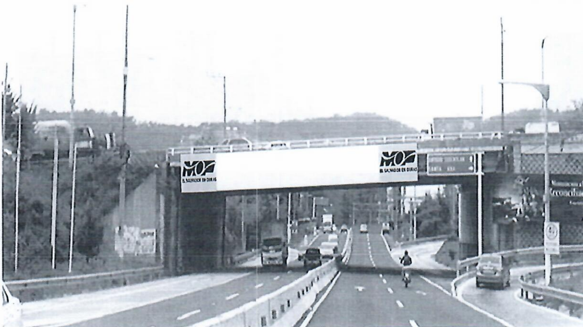
Puente Sobre boulevard Jerusalén.
