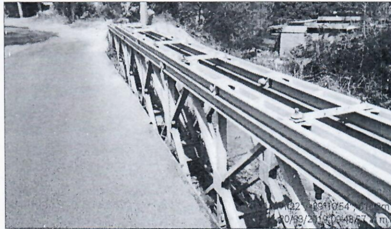
Fotografía N° 2. Vista a una parte de la estructura del puente, compuesta por módulos prefabricados de elementos metálicos.
