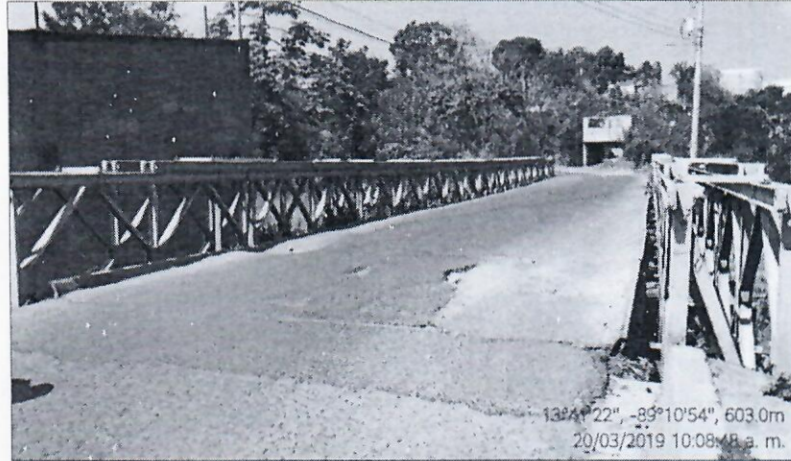
Fotografía N° 1. Vista desde uno de los accesos del puente inspeccionado sobre Quebrada Aceseco.
