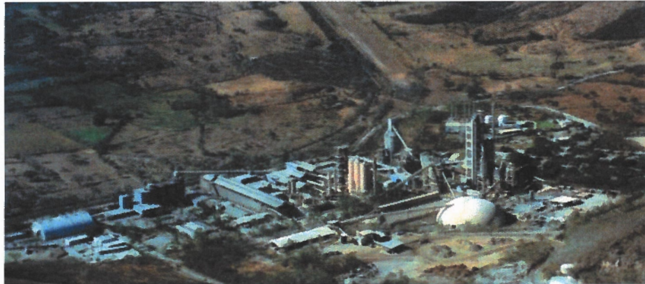
Planta de Cemento El Ronco, Municipio de Metapán
