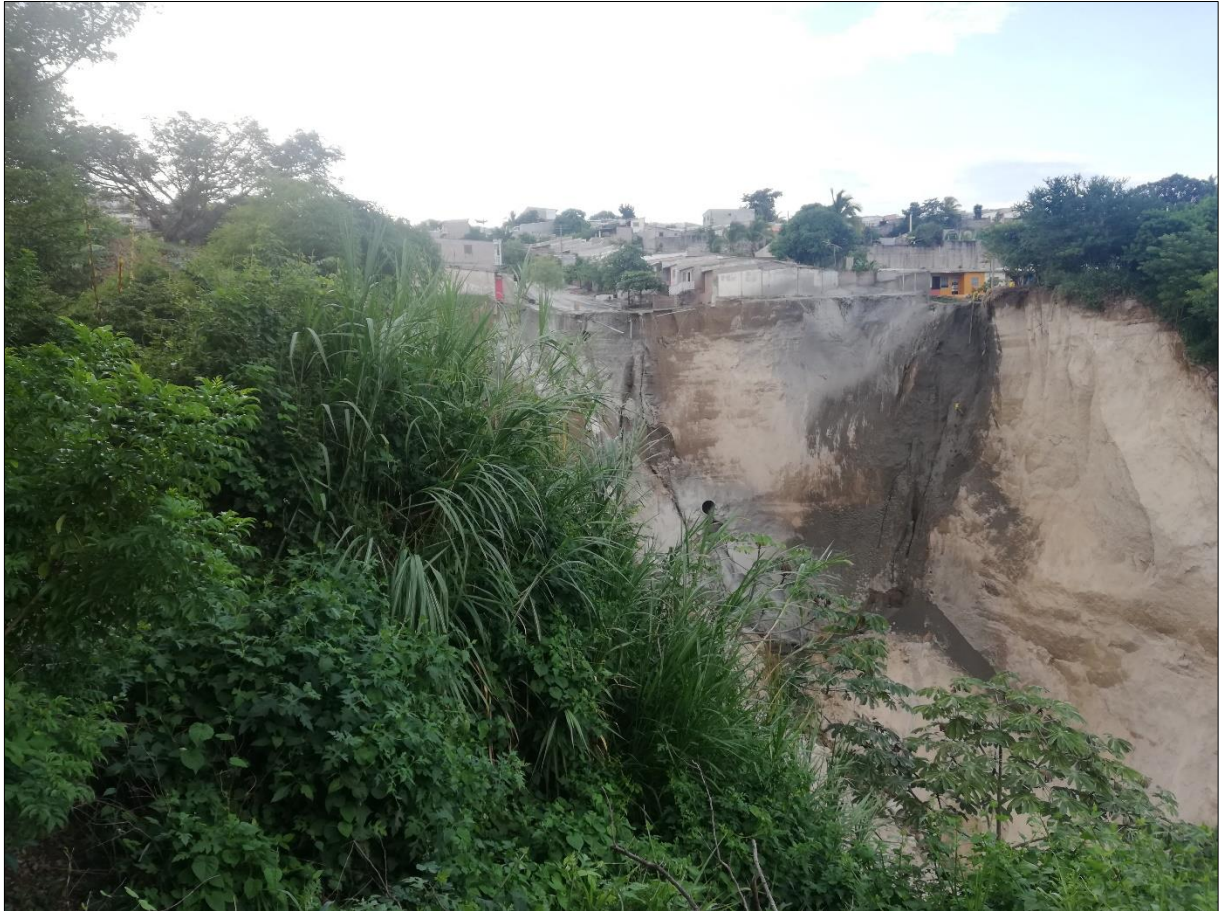
Fotografía 2. Vista del escarpe principal. 24/10/2019
