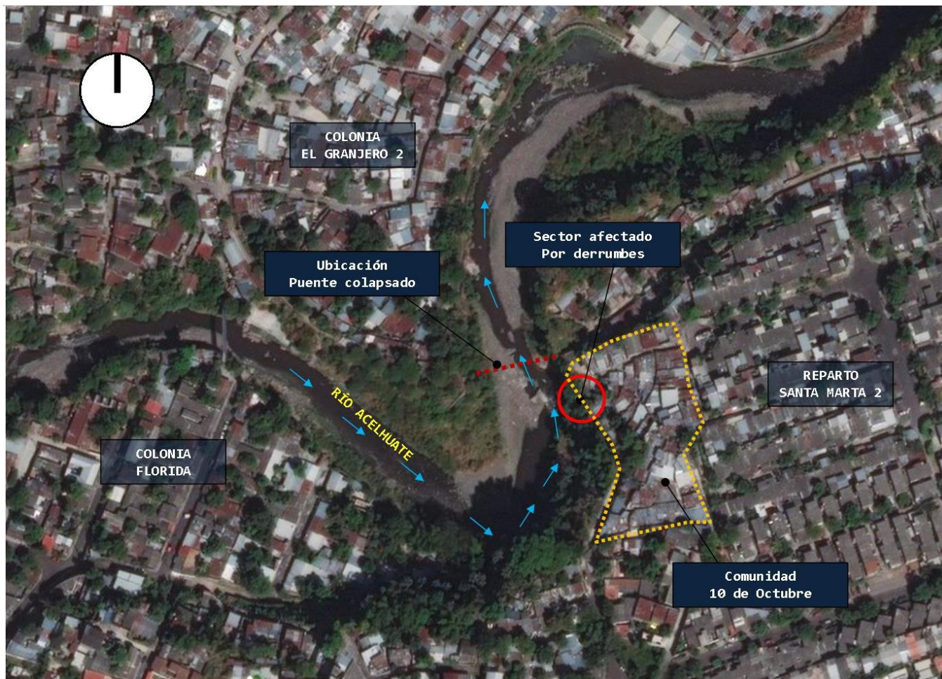
Figura 1. Ubicación de comunidad 10 de octubre, respecto a sector afectado por derrumbes.
