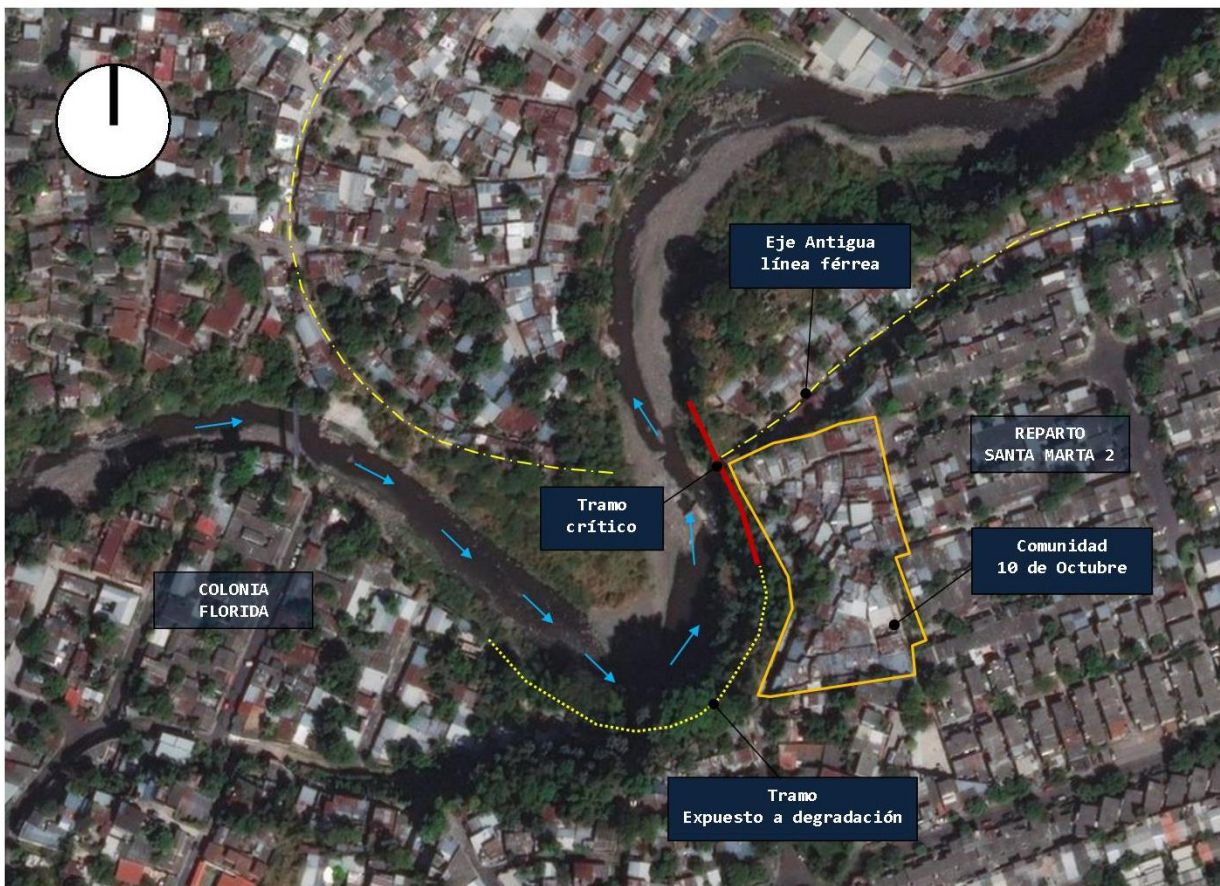
Figura 7. Tramo de margen vulnerable, próximo a final de Calle 2, en Comunidad 10 de Octubre.
