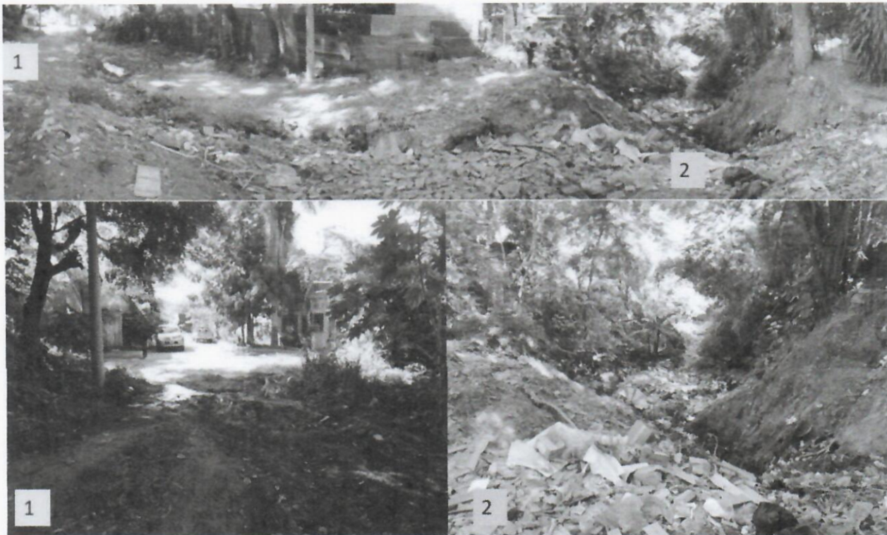
Figura 3. Cabecera de cárcava en final Avenida Principal El Mora, entre Pasaje No.4 y Pasaje No. 5 de Colonia Álvarez. (1) Punto de ingreso de escorrentía sobre Avenida Principal Los Mora; (2) Cabecera de cárcava.
