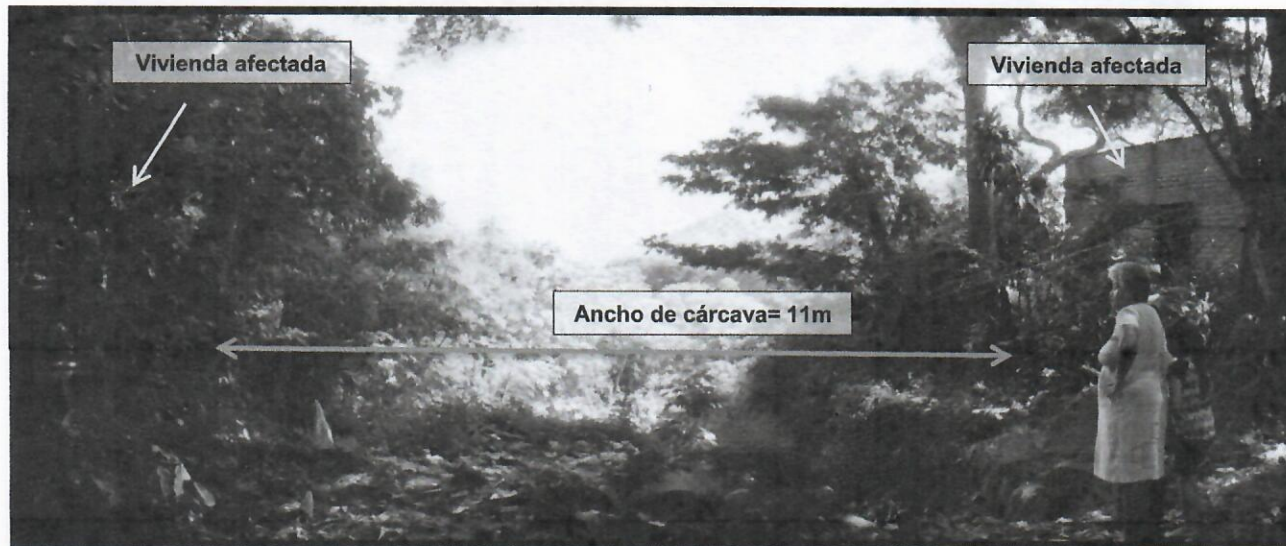
Fotografía 1. Panorámica de la corona de la cárcava, formada sobre el ancho de rodadura de la Avenida Principal, pueden observarse viviendas vulnerables a ambos lados de la misma.
