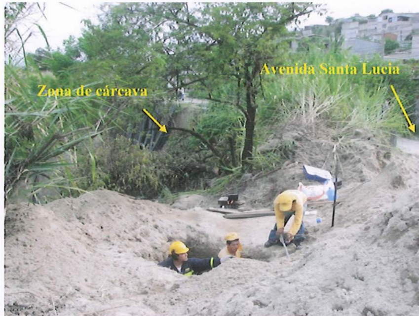
Fotografía 3. Personal de la UIDV-VMOP y DMV-VMOP, realizando trabajos para obtener muestra inalterada (zona costado Norte de la cárcava). Ver detalle de la muestra en fotografía, 4. Fecha: 29 de agosto de 2008.
