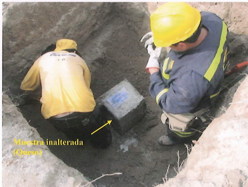
Fotografía 4. Detalle de muestra inalterada (zona costado Norte de la cárcava). Fecha: 29 agosto de 2008.
