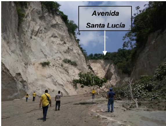
Fotografía 9. Vista desde la parte inferior del canal hacia la Avenida Santa Lucía. Nótese el arrastre de la vegetación en los deslaves de las márgenes.
