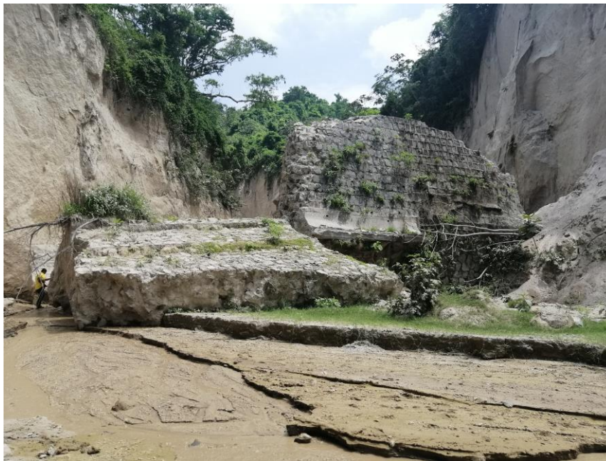
Fotografía 1. Muro colapsado debido a la socavación del cauce.
