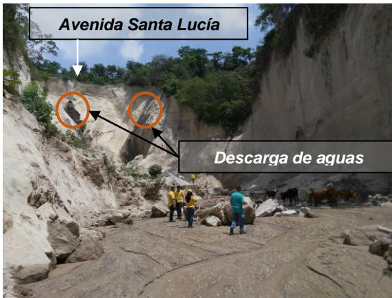
Fotografía 11. Vista de las descargas de aguas lluvias desde la parte inferior del canal hacia la Avenida Santa Lucía.
