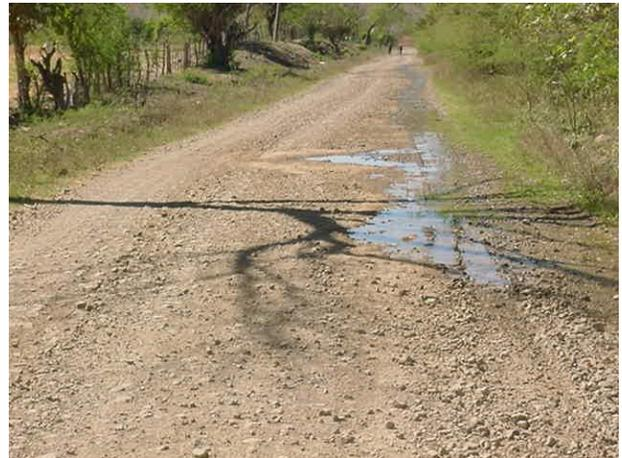
En el Cuadro No. 3.5 se tiene la distribución del estado actual de las cunetas. Nótese que en las de tierra se tiene una condición del 97.86% que se encuentra en estado obstruido y solamente un 2.14% en condición buena.
