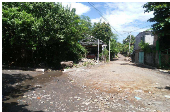
Fotografía No. 6. Vista de la vía desde el final del proyecto. A la izquierda quebrada El Paterno.
