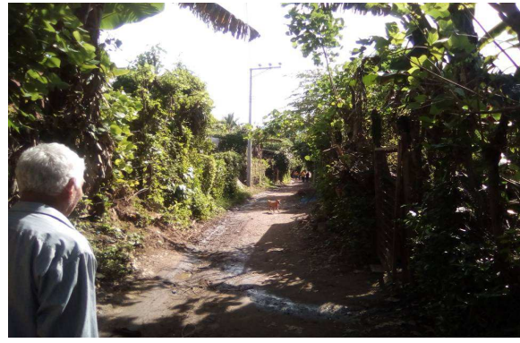
Fotografía No. 2. Aguas servidas que atraviesan la sección transversal de la vía entre lotes.
