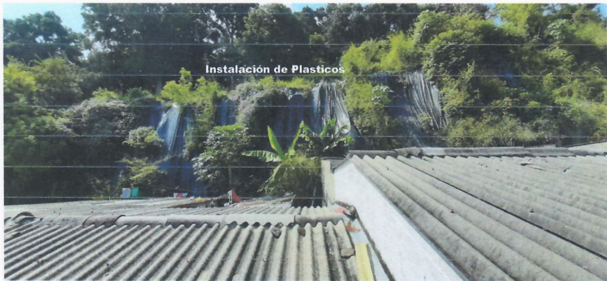
Imagen 5 Vista del deslizamiento sobre techos de viviendas Polígono H e I.
