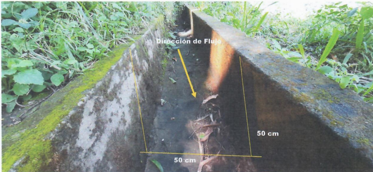
Imagen 7 Dirección y Geometría de canaleta actual
