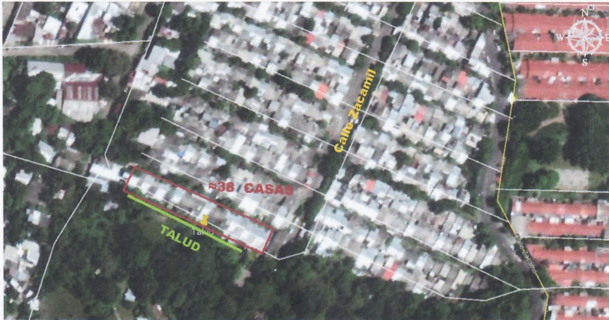
Imagen 2 Ubicación del talud con problemas de deslizamiento.
