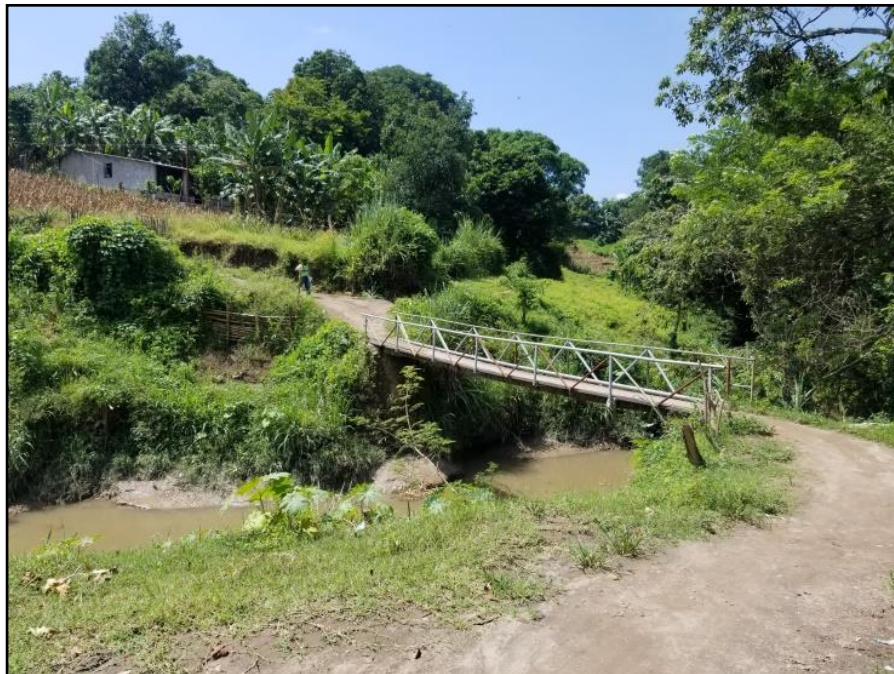
Fotografía N°2. Emplazamiento de puente peatonal sobre Quebrada Invernal.
