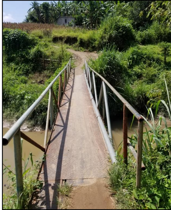
Fotografía N°1. Puente peatonal metálico
