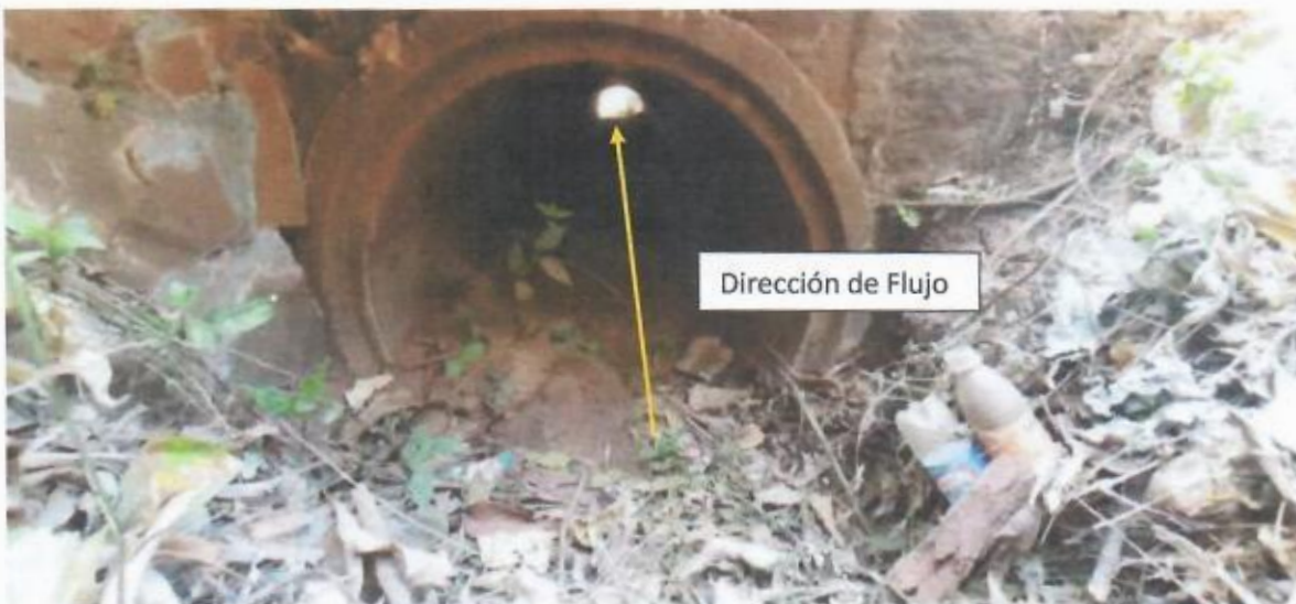
Figura 5. Dirección de flujo de drenaje transversal LIB22S hacia vaguada de invierno en estudio.
