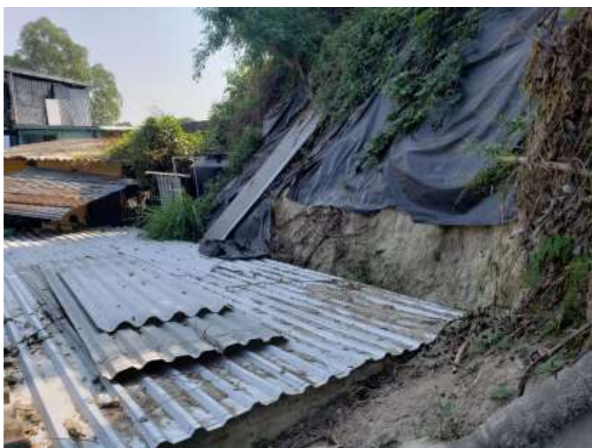
Figura 4. Techo de vivienda afectada correspondiente a zona de ampliación
