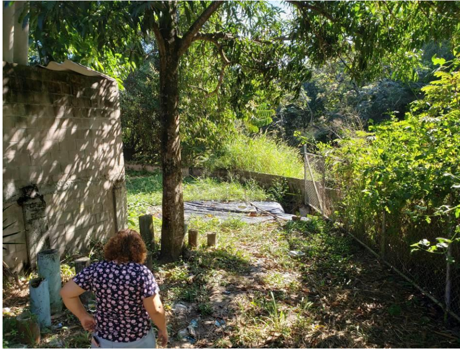
Imagen 3 Vivienda ubicada a escasos 5 m de la corona del deslizamiento
