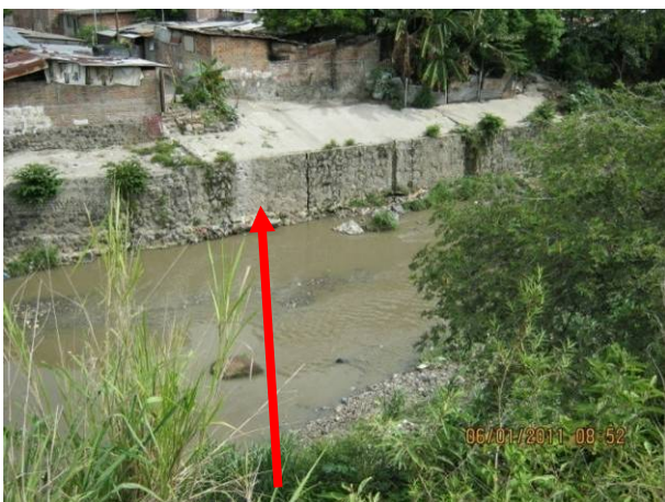
Fig.2 Muro de Mampostería existente en buen estado. (Lat. Izquierdo)
