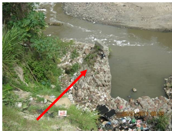
Fig.5 Vestigios del muro de concreto dentro del río en Lateral Derecho al final del proyecto
