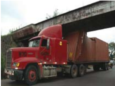
Puente de Ferrocarril, Los Molinos en Costa Rica 28/06/07 Carretera Villa Bonita (Foto Internet)
