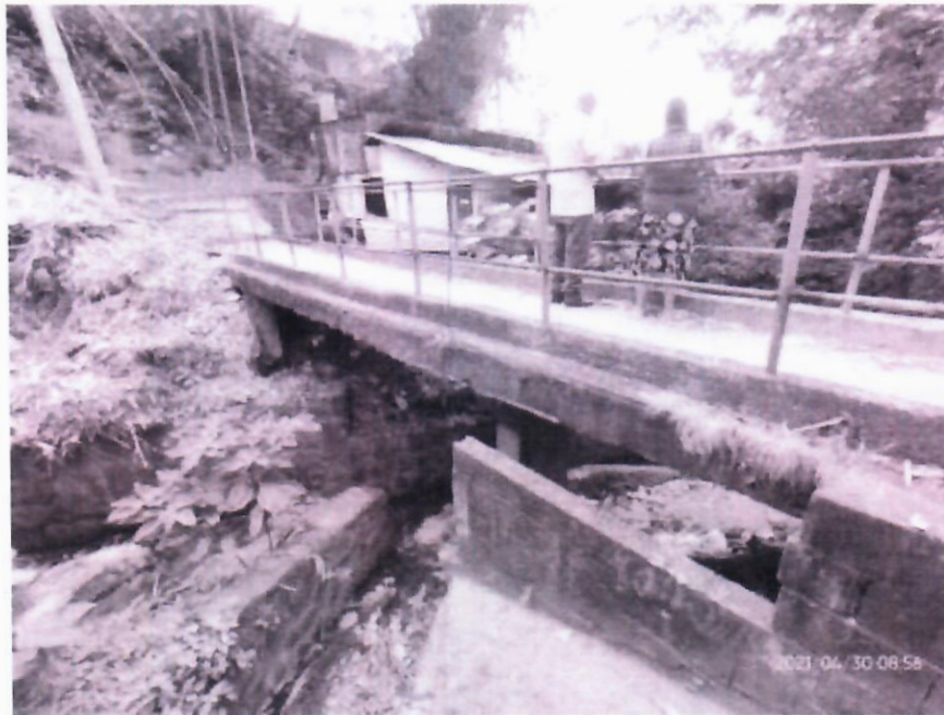
Fotografía 1. Vista general del puente y canales concurrentes desde el oeste.
