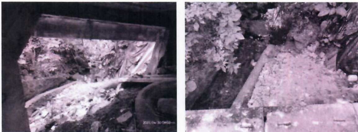
Fotografía 3. Vista de estribo sur a) desde la parte inferior b) desde la plataforma del puente.
