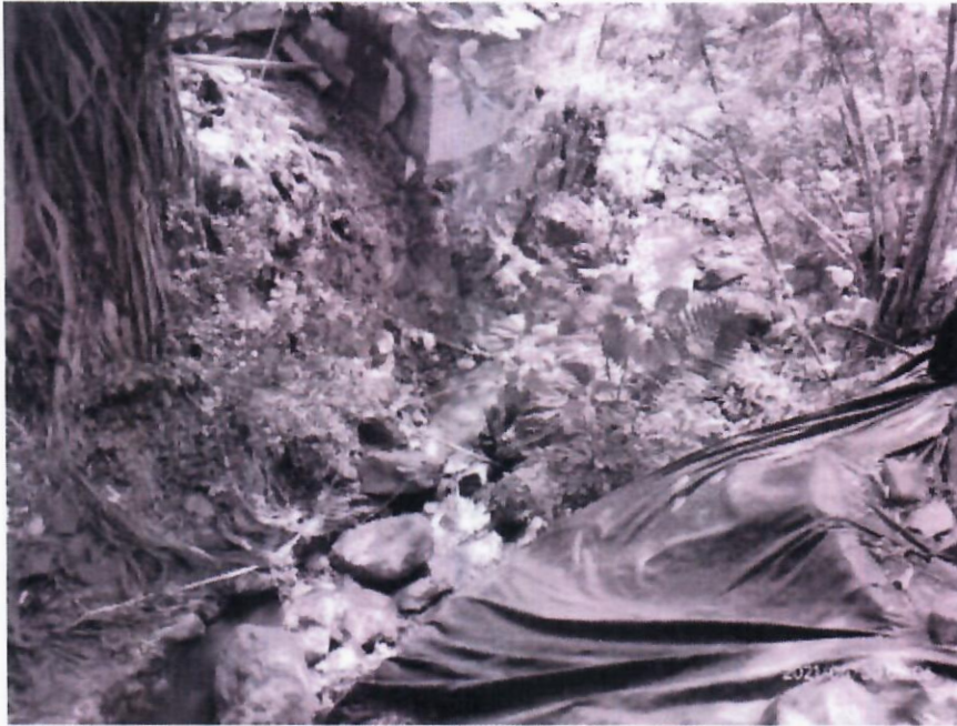
Fotografía 4. Vista desde sector erosionado.
