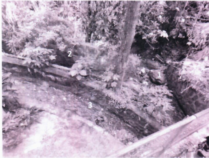
Fotografía 2. Vista de confluencia de sistemas de agua lluvia y Quebrada El Murciélago.
