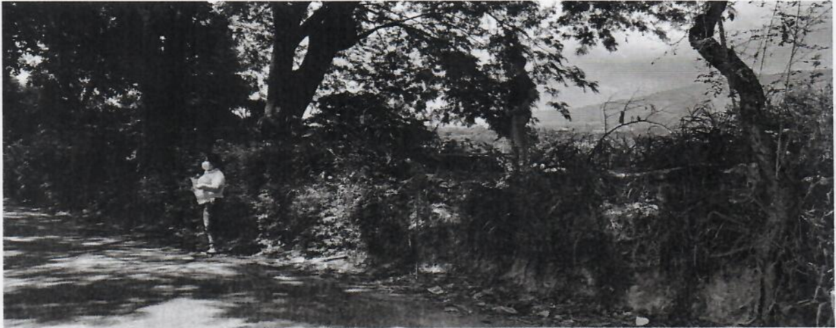
Imagen 7 Espacio en la corona del talud.
