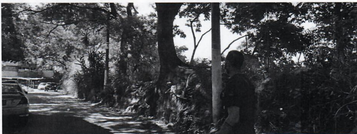
Imagen 6 Desnivel entre el talud y la calle interna de los edificios
