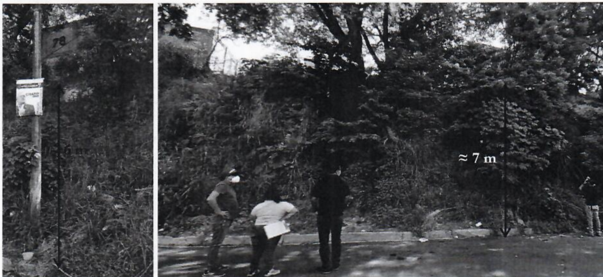
Imagen 5 Vista general de altura del talud
