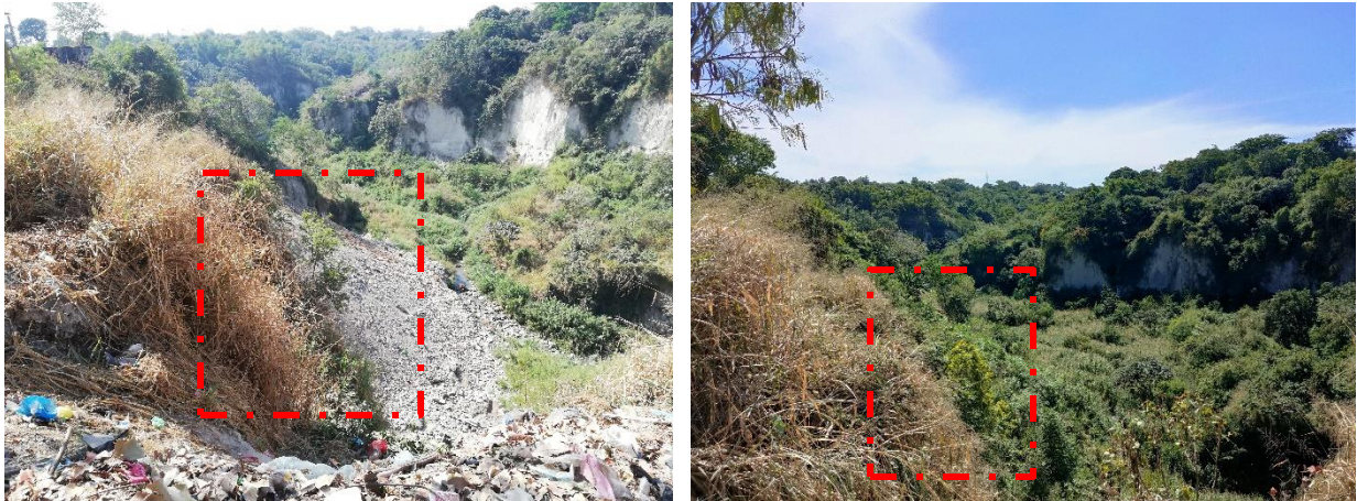
Figura 5. Sucesión ecológica acelerada en zona de ripio. Cauce de aguas mínimas alejado del pie del talud.
