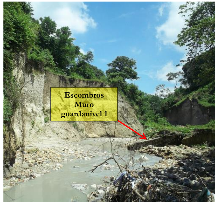
(a) Esquema de ubicación escombros de muro guardanivel construido en 2008. (b) Vista desde cauce de remanentes de muro guardanivel 1.
