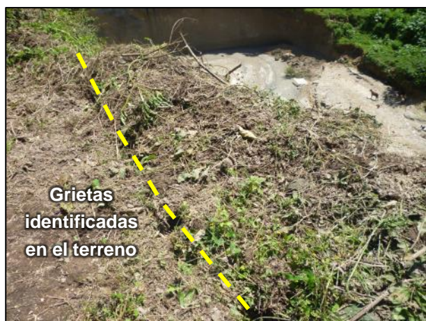
Imagen 7. Grietas identificadas en el terreno, paralelas a la corona del talud entre el Pasaje San Miguel y final Calle Veracruz.
