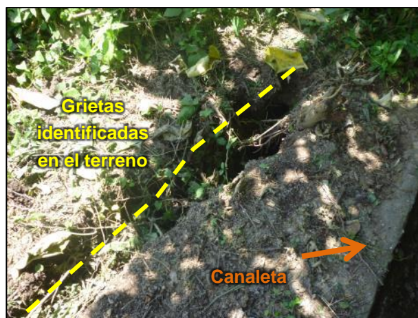
Imagen 7. Grietas identificadas en el terreno, paralelas a la corona del talud entre el Pasaje San Miguel y final Calle Veracruz.
