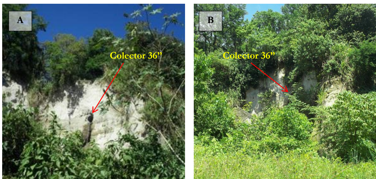
Imagen 4. Vista general de condiciones encontradas en cárcava sobre final Calle Veracruz, Reparto Los Santos I. (A) Condiciones observadas en diciembre de 2011; (B) condiciones observadas en septiembre de 2014.
