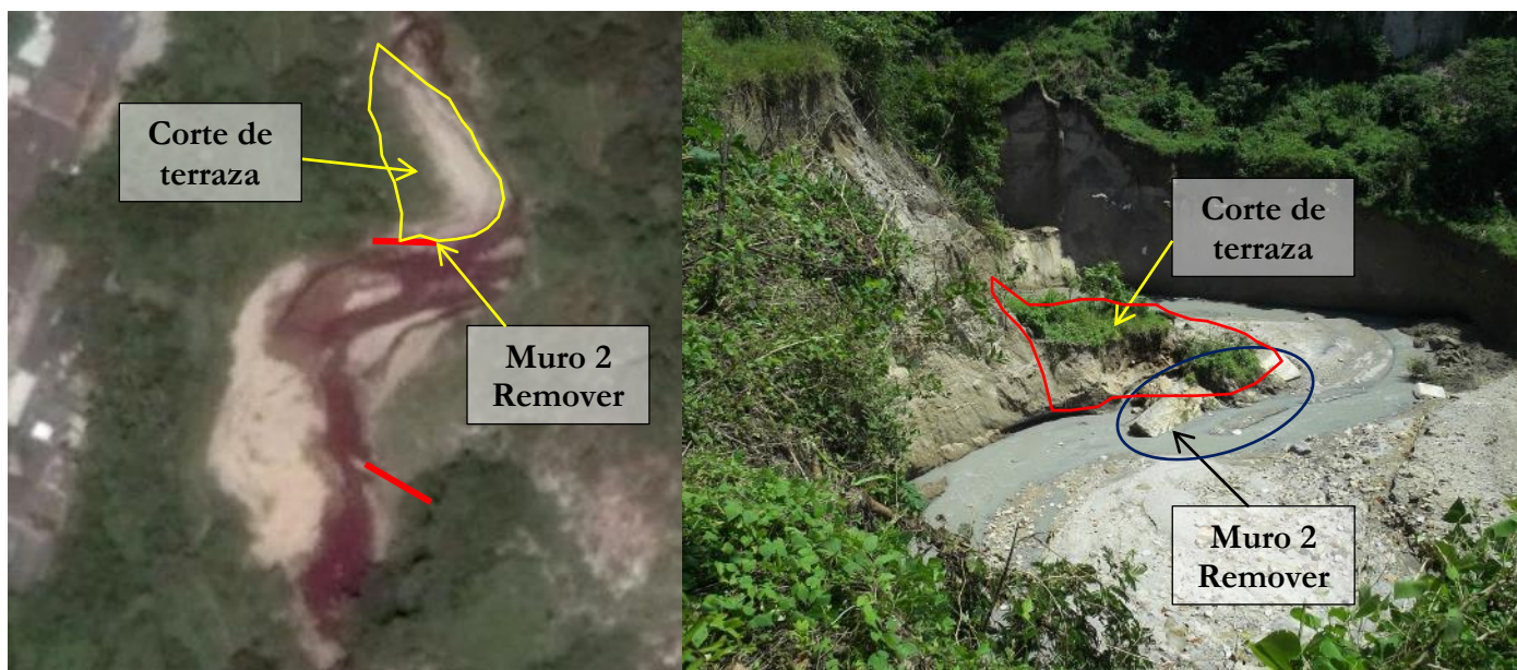
Imagen 15. Esquema de trabajos de rectificación propuestos en margen izquierda de Río Sumpa, cercanías de final Pasaje San Miguel.
