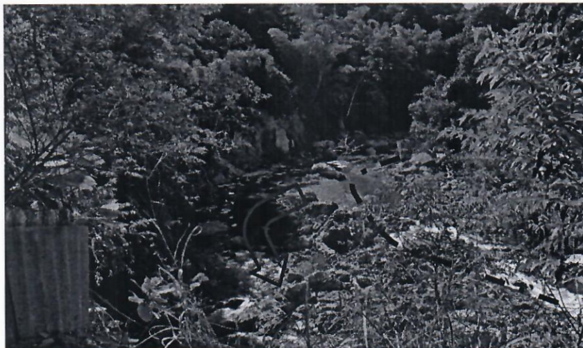
Figura 8. Vista desde casa #1 hacia aguas arriba. Nótese el desplazamiento del cauce de aguas mínimas hacia margen derecho y la disposición de sedimentos en margen izquierdo
