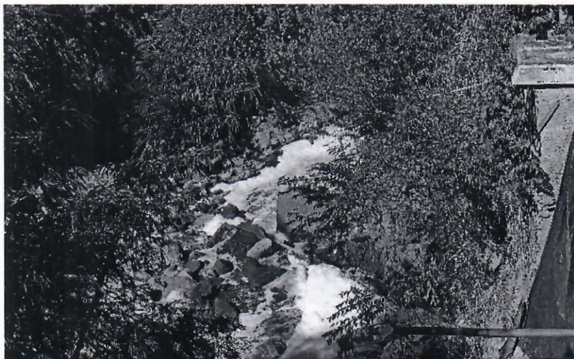
Figura 3. Vista de base de puntos de desprendimiento en casa # 1.
