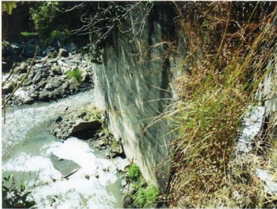
Fotografía 19. Parte frontal del muro.
