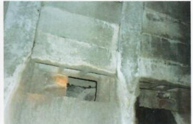
Fotografía 33. Descarga a través del hueco de 2 bovedillas.
