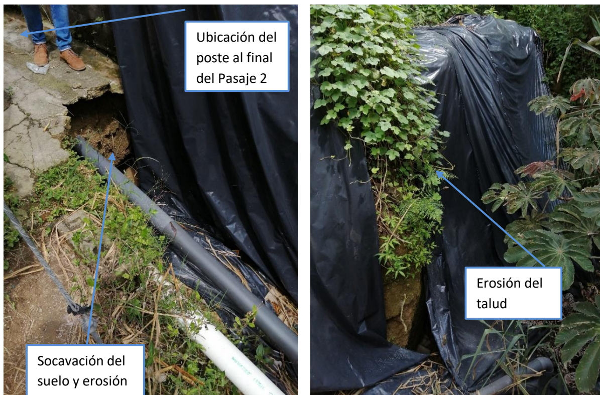
Fotografía 4. Estado actual del final del Pasaje 2.
