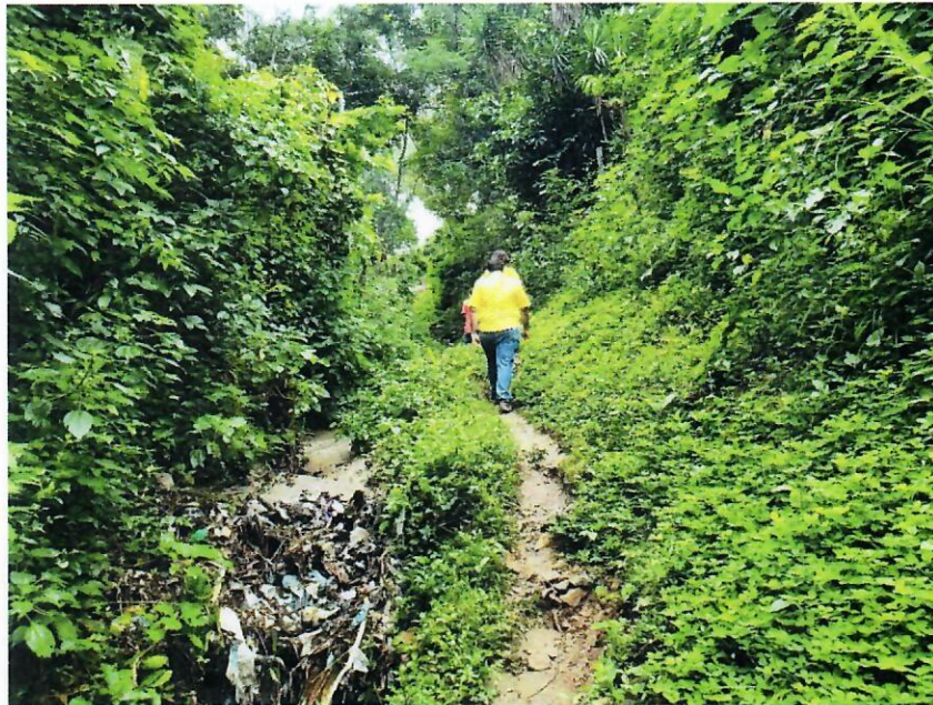
Fotografía N°3. Sendero después de puente peatonal para salir a la Carretera; nótese erosión en costado izquierdo por falta de obras de drenaje
