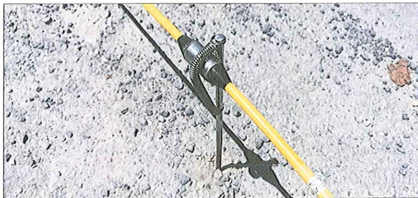
Fotografía N°2. Electrodo instalado en el terreno.
