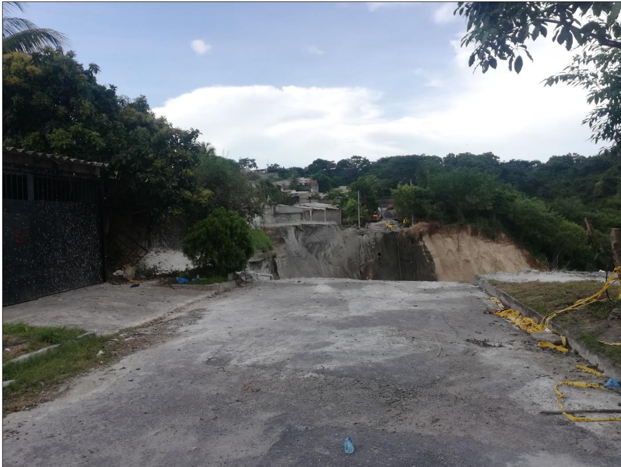
Fotografía 1. Vista de vivienda de Block K desde Avenida Santa Lucia. 24/10/2019
