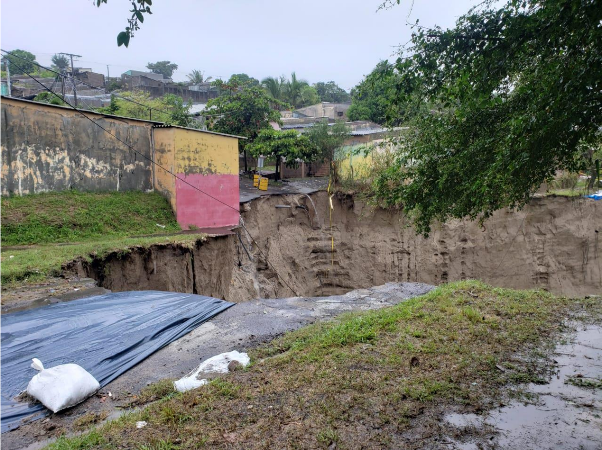
Fotografía 4. Vista de vivienda #1 en Block K desde Avenida Santa Lucía. 15/10/2019
