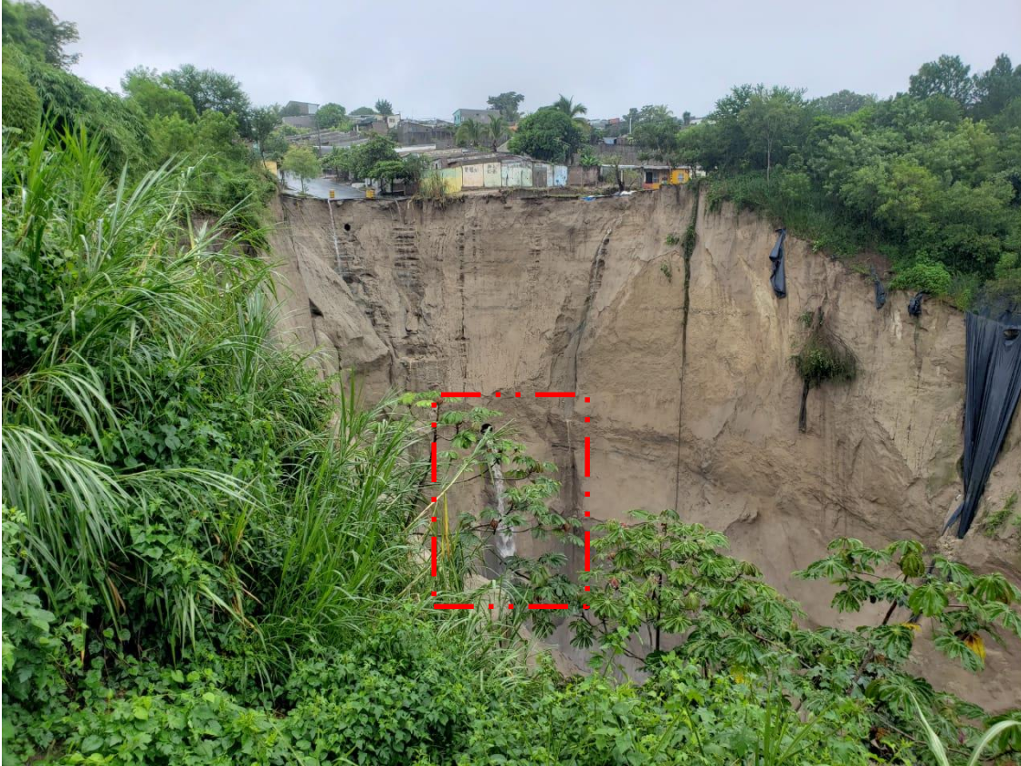
Fotografía 3. Vista del escarpe principal. 15/10/2019 Nótese el flujo en caída libre proveniente de la tubería de 60”
