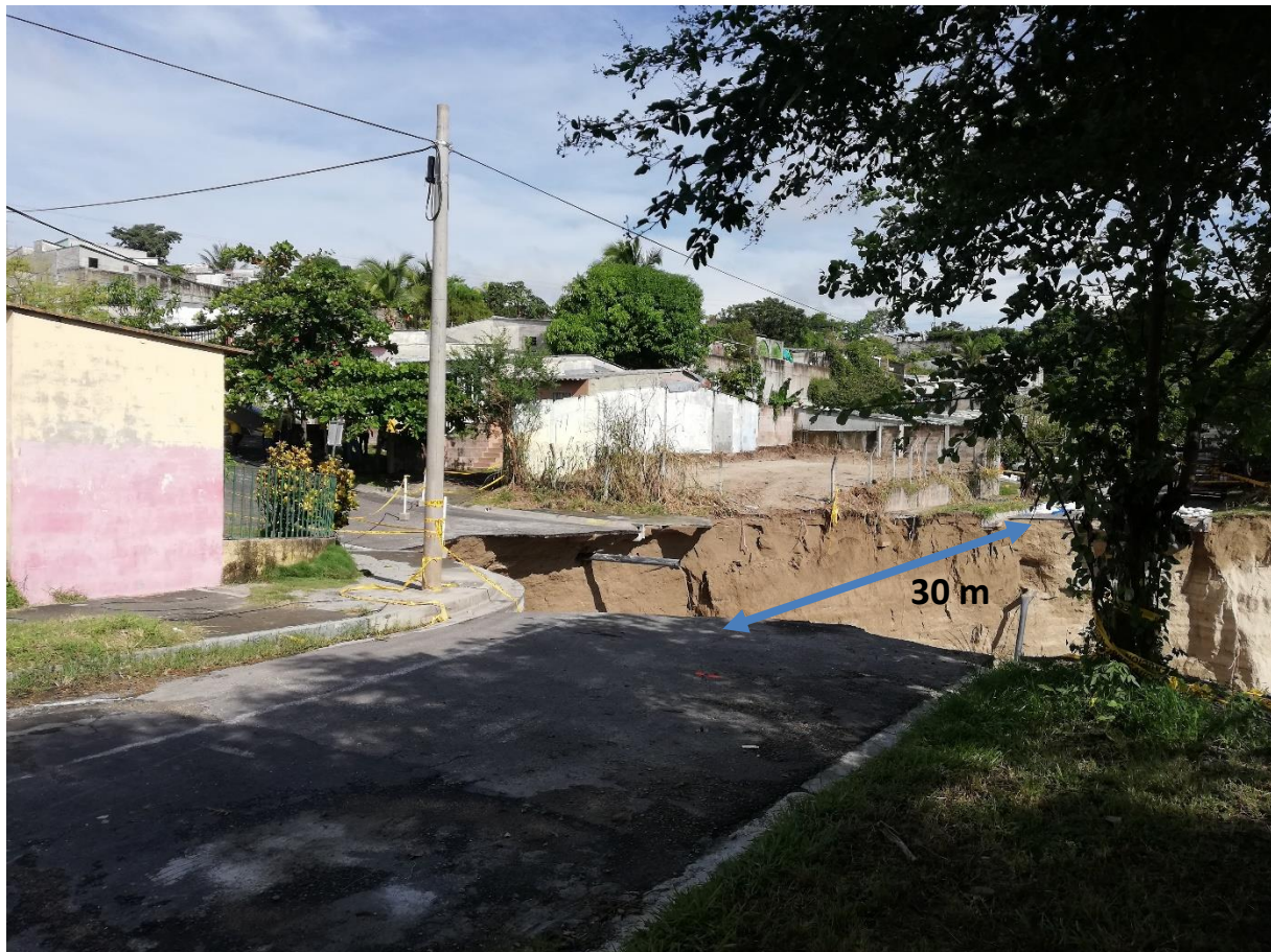
Fotografía 1. Vista de vivienda #1 en Block K desde Avenida Santa Lucia. 14/10/2019
