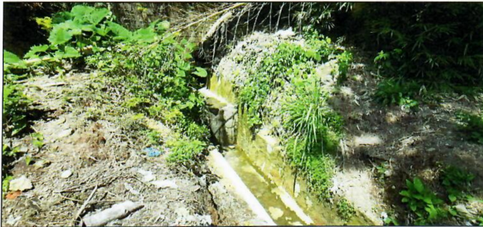
Fotografía N° 2. Canaleta existente en terreno baldío y al costado norte de la Urbanización Santa Úrsula.
