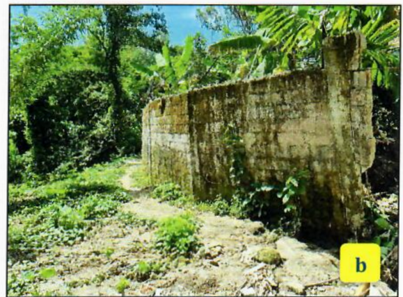
Fotografía N° 4. Daños en muro perimetral de la Urbanización Santa Úrsula. a) Porción
