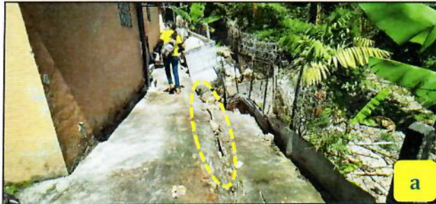
Fotografía N° 5. Daños en pasillo ante colapso de muro de mampostería de piedra, al interior de la urbanización Santa Úrsula. a) Vista oriente - poniente; b) Vista poniente - oriente.
