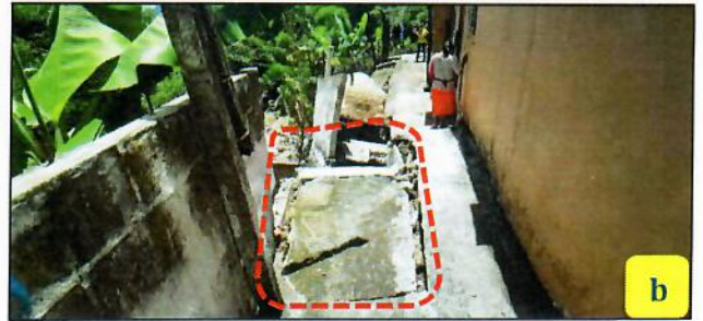
Fotografía N° 5. Daños en pasillo ante colapso de muro de mampostería de piedra, al interior de la urbanización Santa Úrsula. a) Vista oriente - poniente; b) Vista poniente - oriente.
