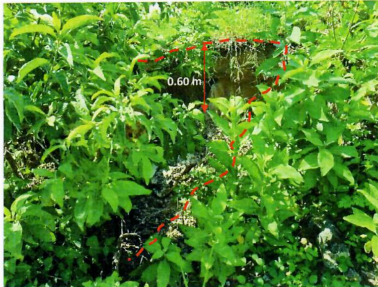
Fotografía N°1. Inicio de surco de erosión.
