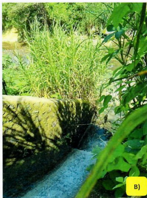
Fotografía N°4. A). Tubería de 72" en punto de descarga en gradas disipadoras. B) gradas disipadoras.
