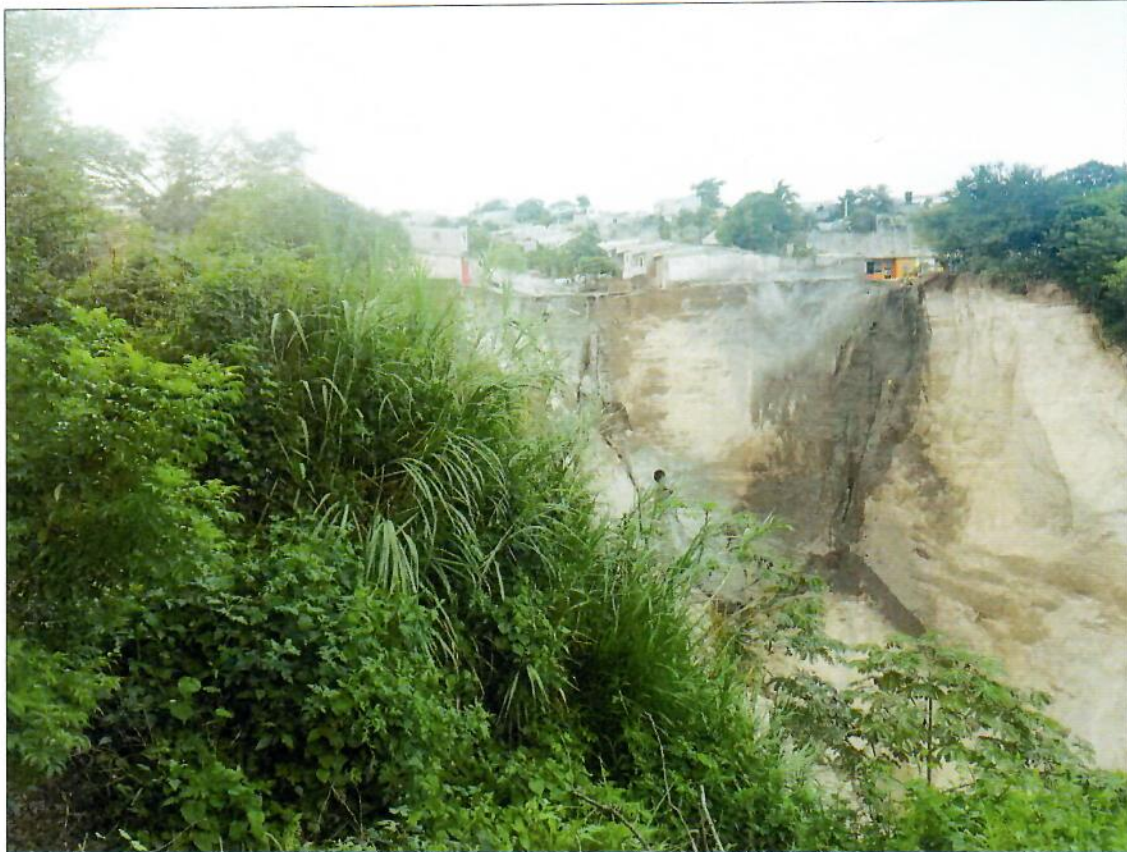
Fotografía 2. Vista del escarpe principal. 24/10/2019
