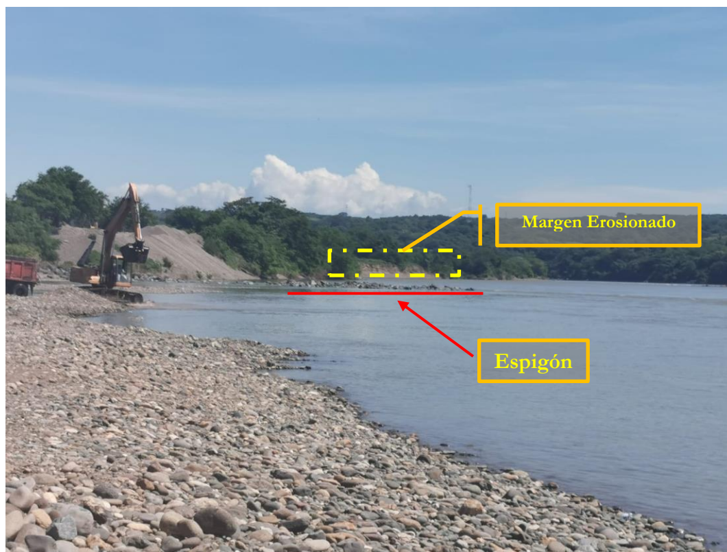
Fotografía No.4 Sector de explotación de bancos de pétreos.
