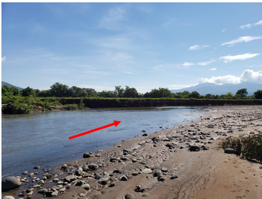
Fotografía 6. 300 m hacia aguas abajo, la erosión se encuentra hacia margen izquierdo y el depósito de arena hacia margen derecho
