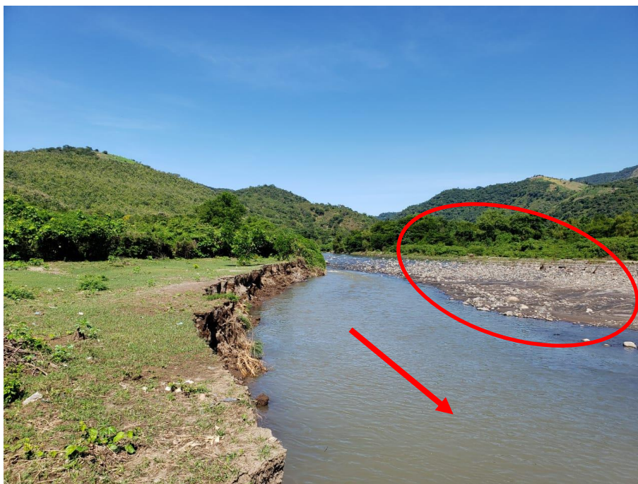
Fotografía 4. Erosión en margen derecho de Río; obsérvese banco de arena depositado en margen izquierdo
