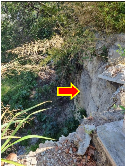
Fotografía N° 7. Condición de falta de protección que muestran algunas porciones de la margen izquierda de la Quebrada La Mascota, por ocurrencia de deslizamientos.
